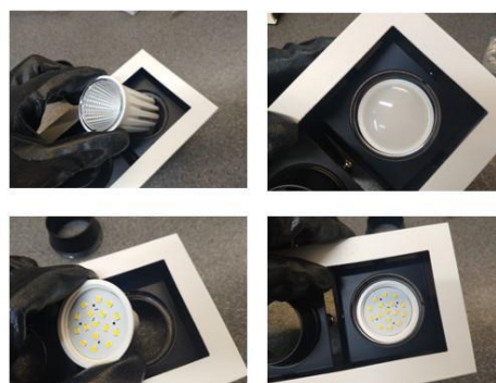
3. Insertar la lámpara en la base
